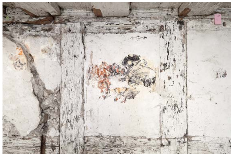
_MG_0136 Kirchenstrasse 3, 1. OG (Treppenhaus)
