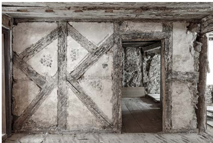
_MG_0144 Kirchenstrasse 3, 1. OG (Treppenhaus)
