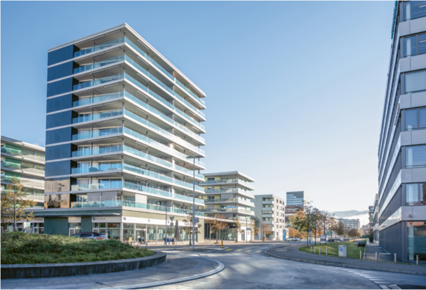
Kreuzung Nord- und Feldstrasse. (Bild VDW)
