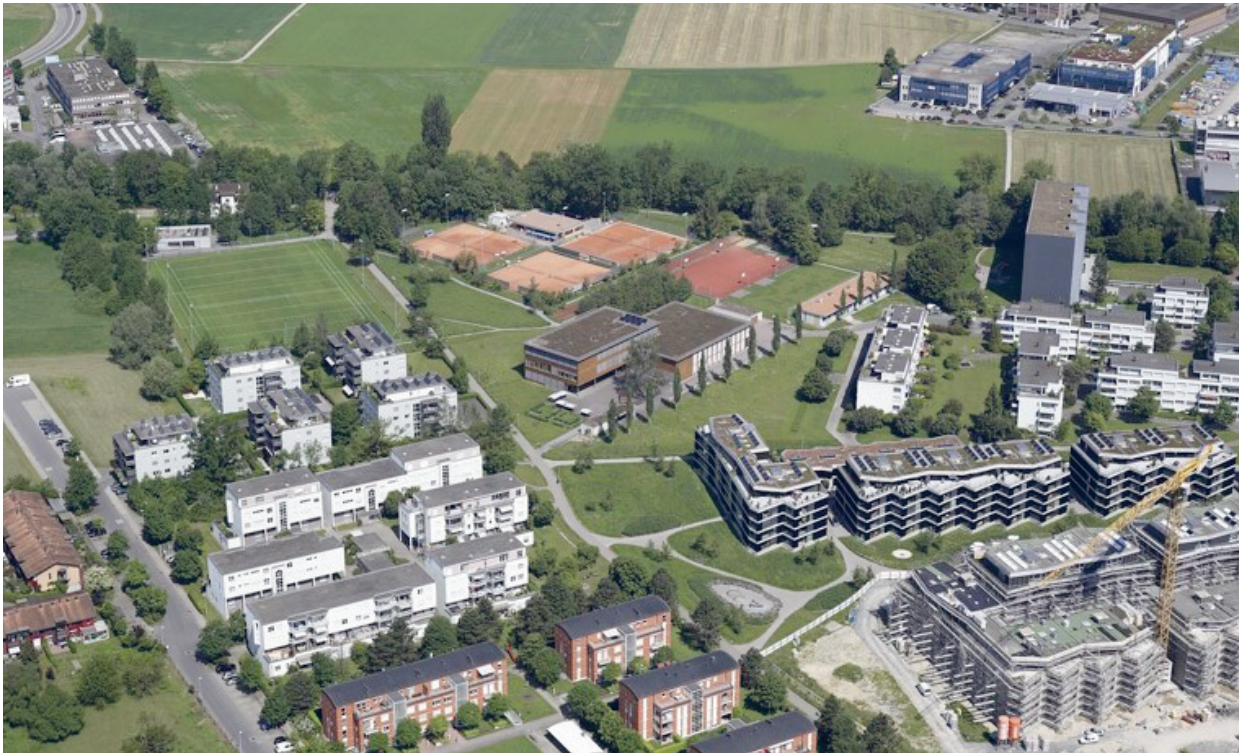
Luftbild: Schulanlage Riedmatt und Nachbargrundstücke (Foto: Andreas Busslinger, andreasbusslinger.ch, 2014)
